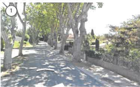
1 RÉFECTION DU TROTTOIR AU SUD
