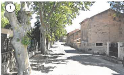
REPRISE DU GARDE-CORPS EN UN MURET PIERRE
