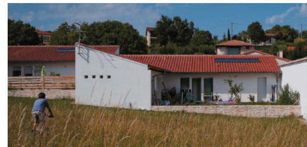
Exemple de traitement soigné du bâti et de l'espace privé qui installe une de co-visibilité relation intéressante avec un espace ouvert. Castelnau Montratier © CAUE 13 - Voir
